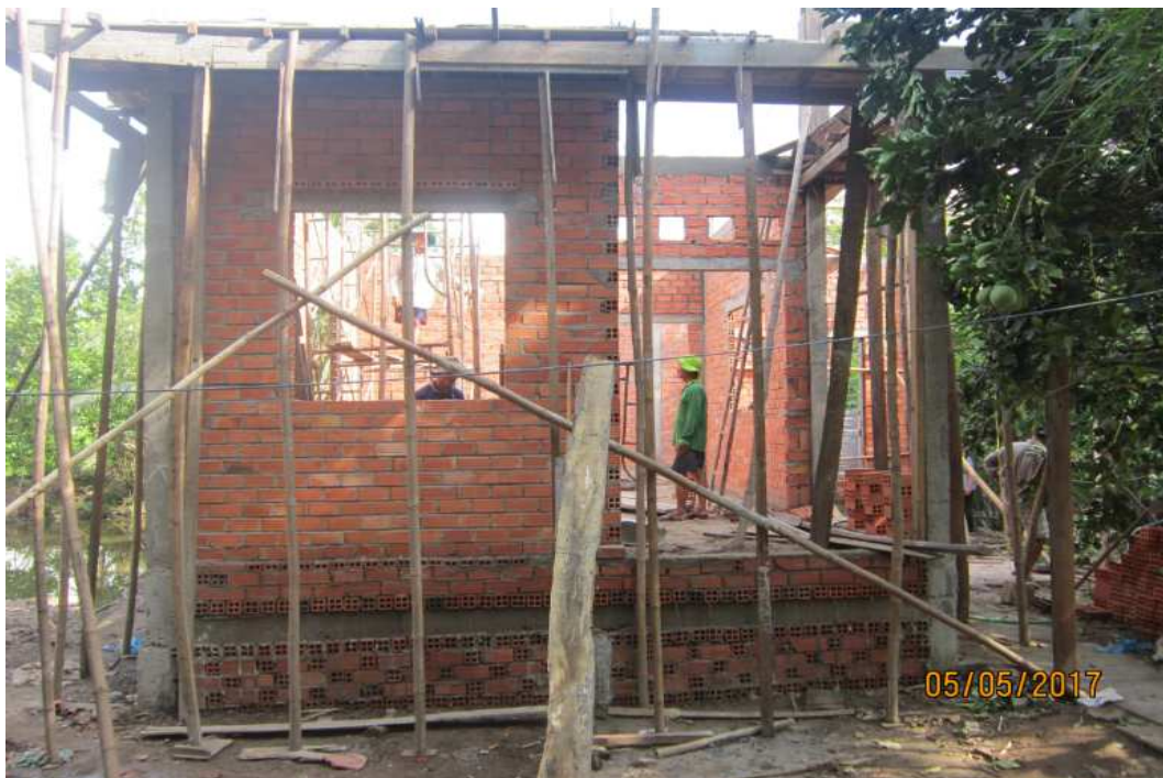
Nhà AC Nguyễn Phúc Yên (Vĩnh Long, đang được xây lại, 2017)
